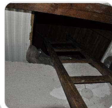
Oberste Geschoßdecke gedämmt mit 5 cm Polystyrol, Zugang zum Spitzboden
