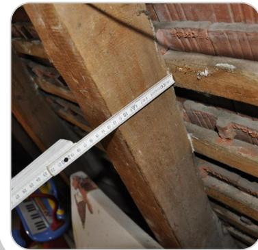
Spitzboden Dach ungedämmt und keine Unterspannbahn
