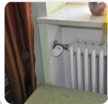
Heizkörper mit Heizkörpernischen, diese sollten gedämmt werden
