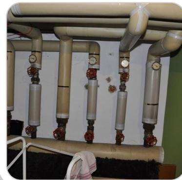
Mediumsgeführte Leitungen bereits ordentlich gedämmt
